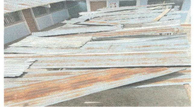
Foto 4: parte superior del techo de la escuela a sustituir.
